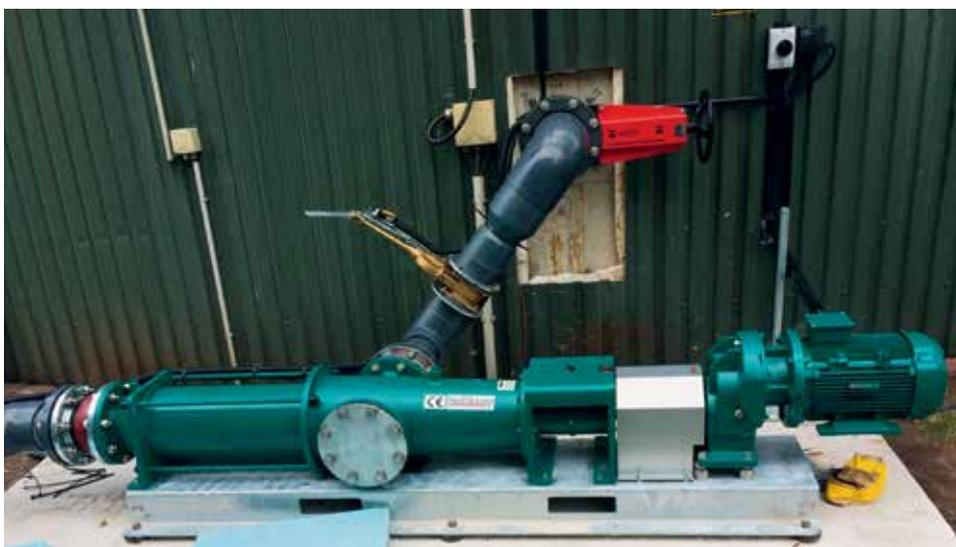
Горизонтальный эксцентриковый винтовой насос в работе на биогазовой установке
