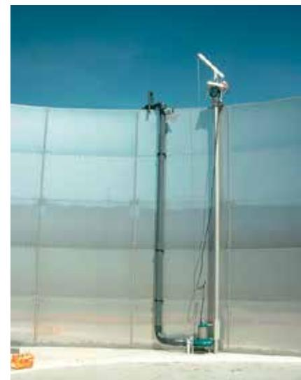
Насос TMP и откачивающая/заполняющая труба
